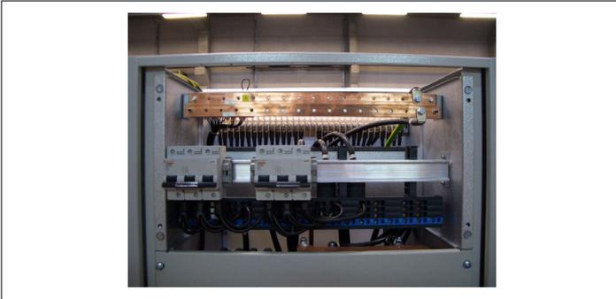
La distribution de sortie AC standard est conçue avec un rail DIN de 35 mm, un bornier MultiClip et des barrettes à bornes de cuivre N/PE ; elle est intégrée en tant qu'élément de l'armoire.
